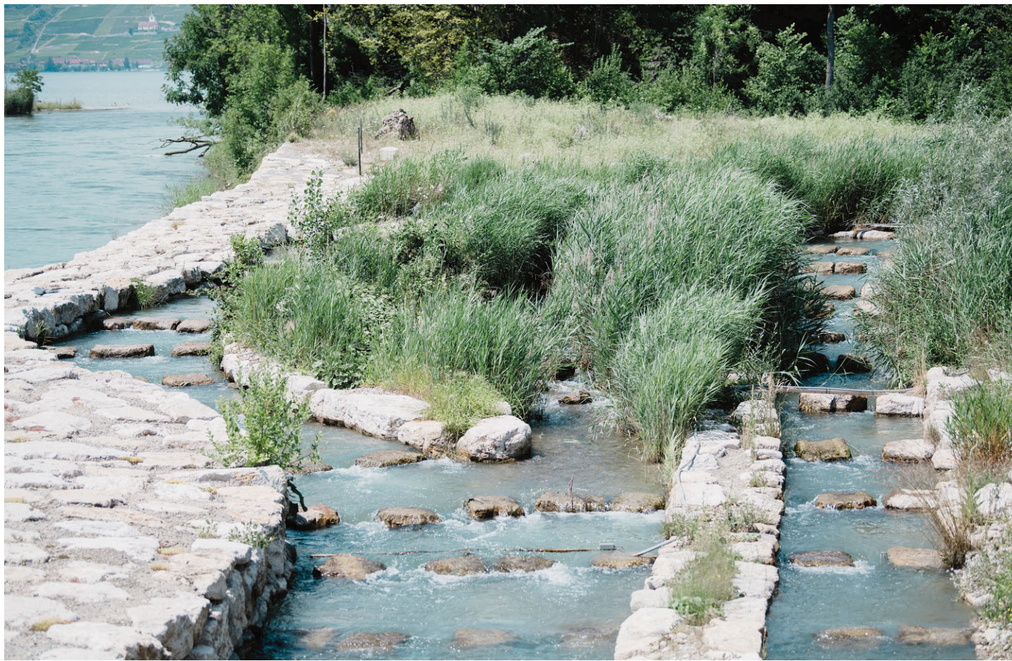
Le canal de dérivation compte trois entrées différentes. Les chemins se rejoignent au centre avant de se séparer.
