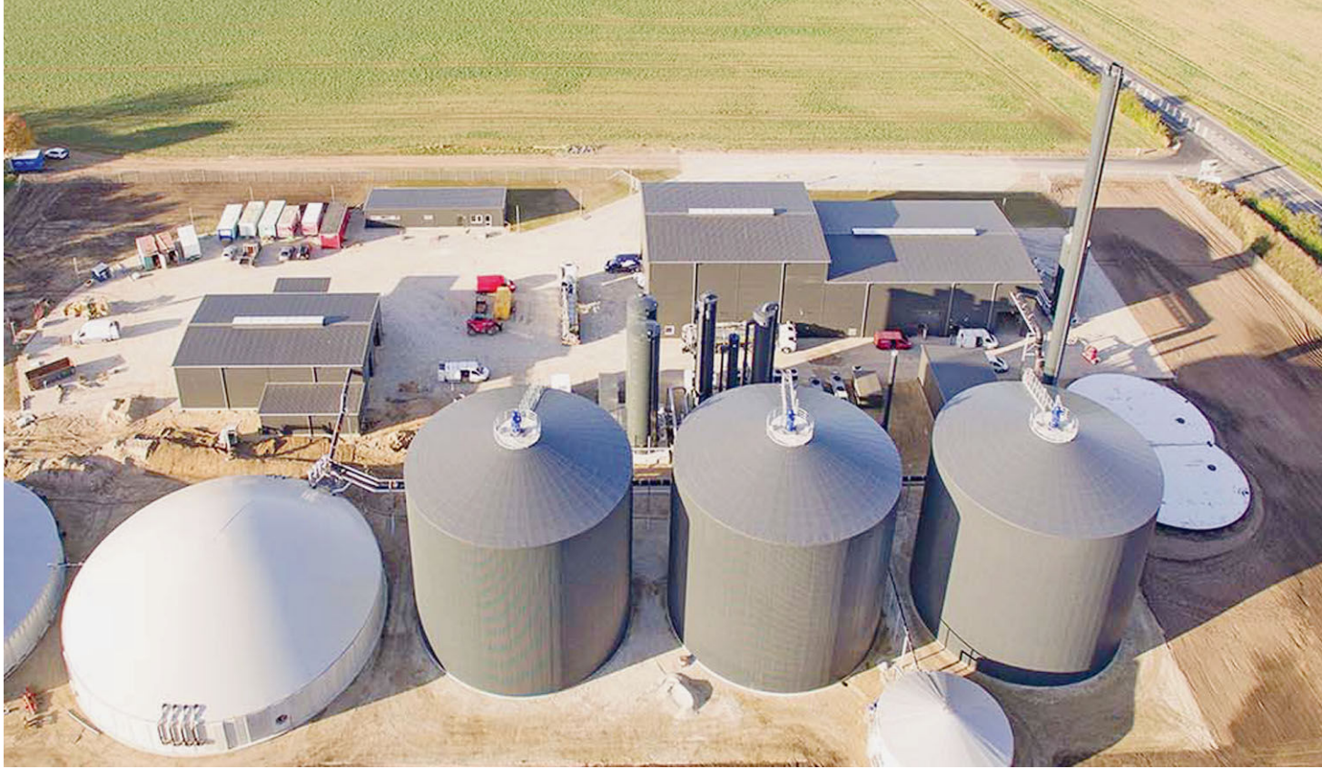
L'installation de biogaz Nordfyn, au Danemark, où est produit le biogaz fournit par ESB. Il est certifié «naturemade star», ce qui atteste d'une fabrication aussi respectueuse de l'environnement que l'état actuel de la technique le permet. Le biogaz danois, tout comme le gaz naturel qu'ESB importe de Norvège, bénéficie également d'un certificat d'origine. ESB
