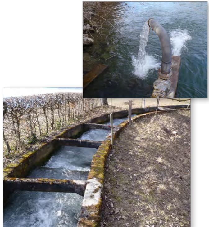
**Abbildung 36:** Alter Beckenpass des Kraftwerks Hagneck. Inklusive Lockwasserzugabe ins untere Becken (oben). Fotos WFN 2011.
