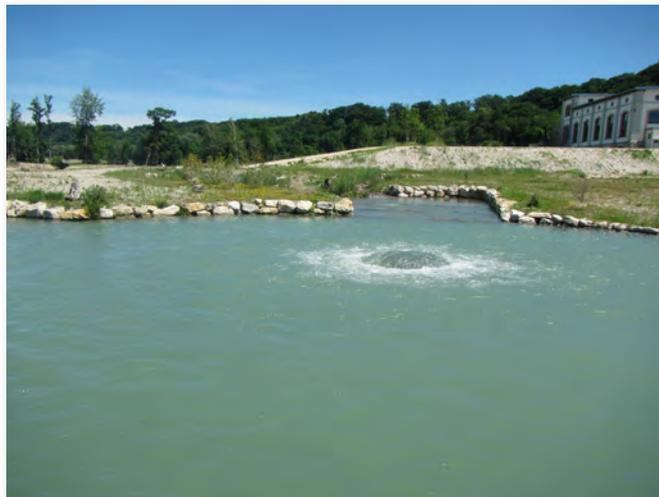
**Abbildung 34:** Zusätzliche Dotation des Verteilbeckens via Maschine 4.
