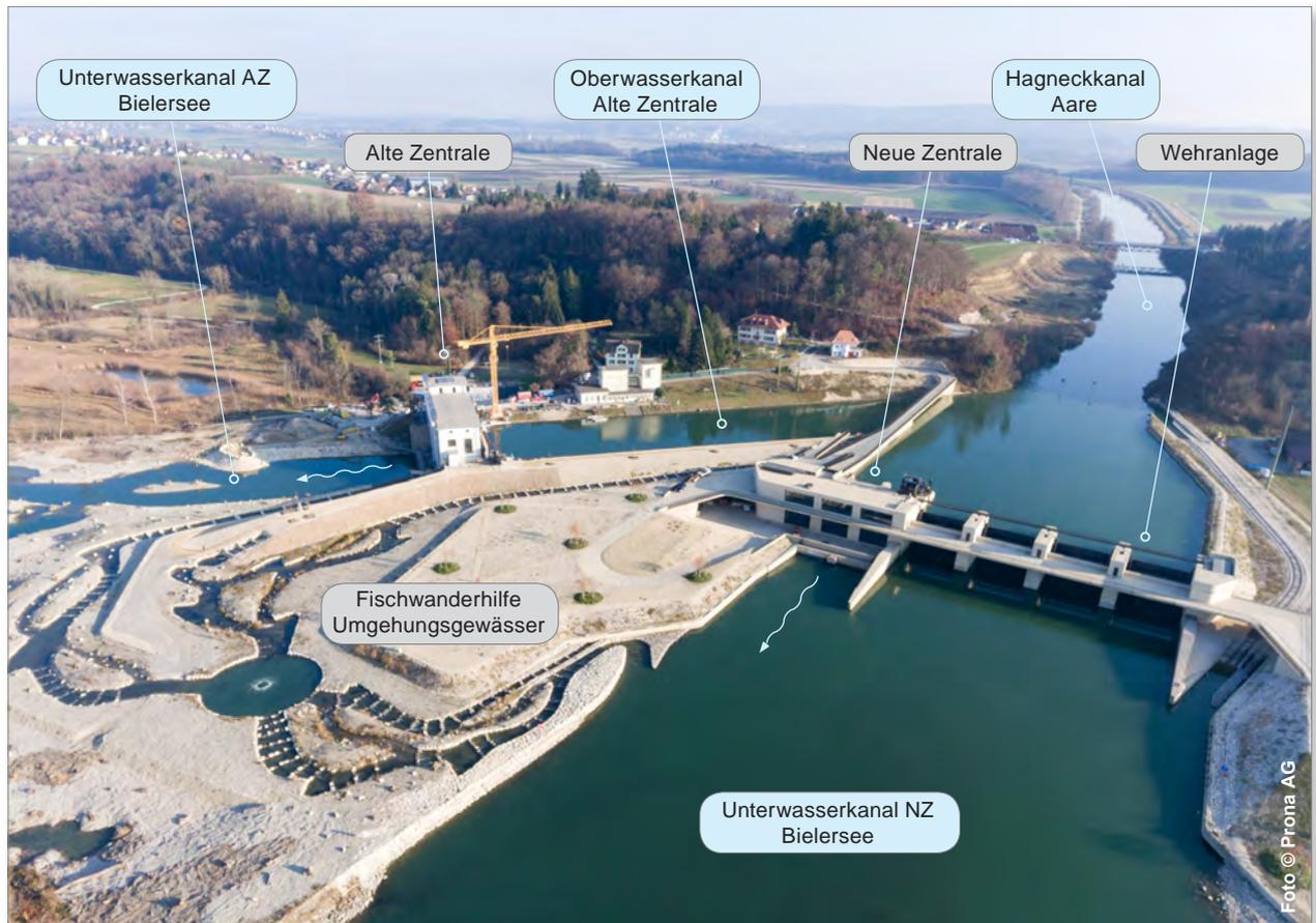
Abbildung 5: Übersicht der Anlage Kraftwerk Hagneck.
