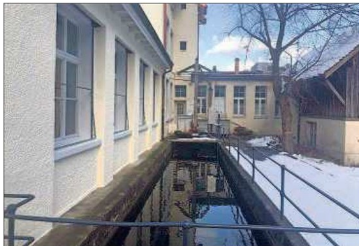
La centrale produit de l'électricité pour environ 100 ménages
