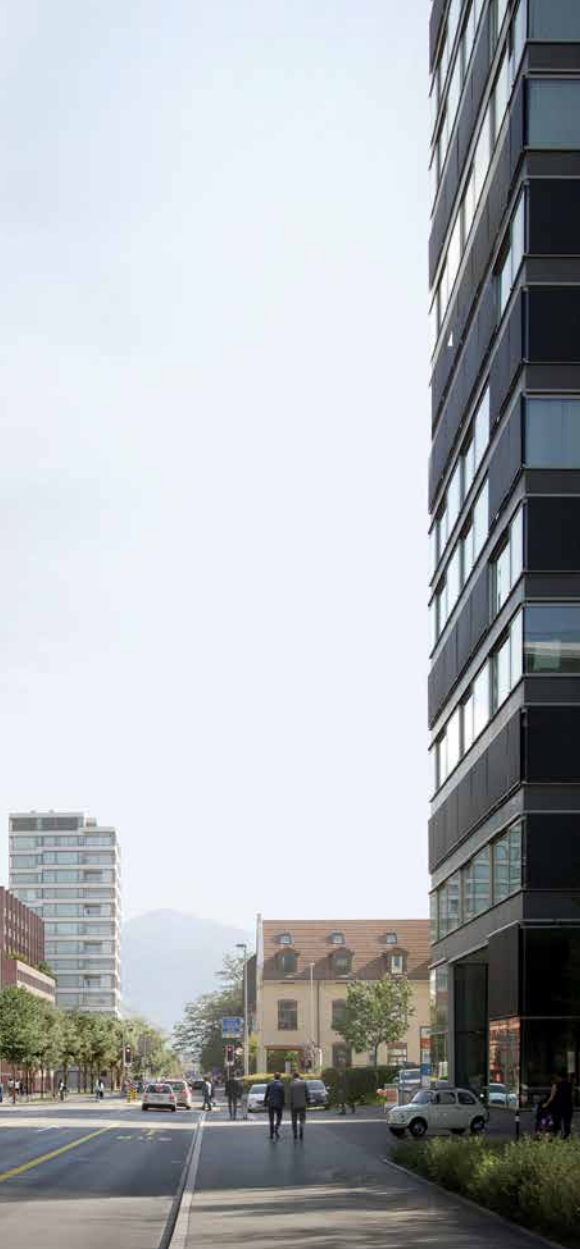
Architektur: Duplex Architekten AG, Bauherrschaft: Urban Assets Zug AG, Totalunternehmer: Implenia Schweiz AG, Holzbaingenieur: WaltGalmarini AG
