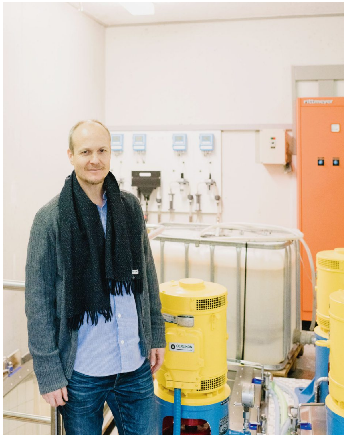
Roman Wiget: Der Geschäftsführer der Seeländischen Wasserversorgung steht neben der Umkehrosiose-Anlage, die das Wasser der Fassung in Worben reinigt. Das Trinkwasser für die Konsumenten sei einwandfrei.
