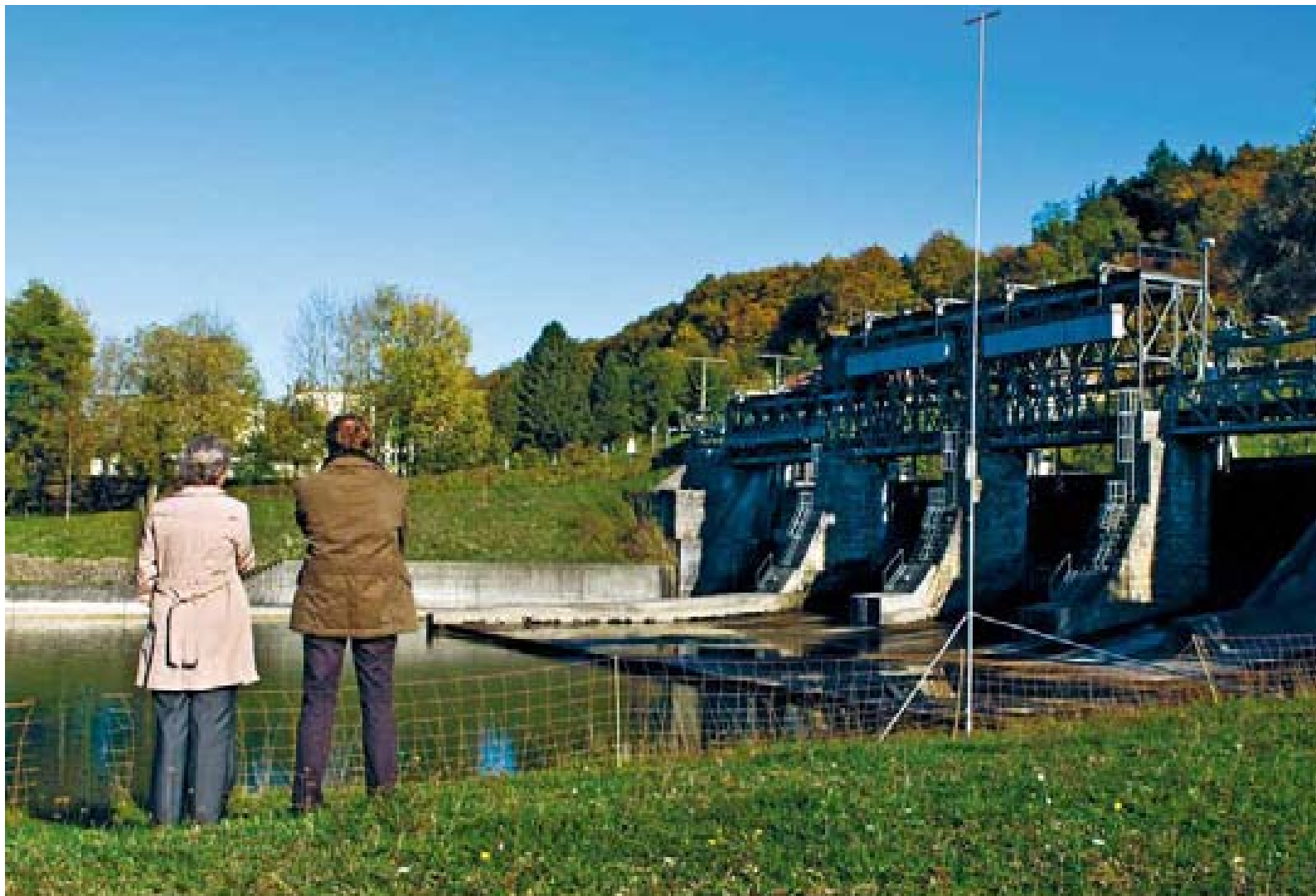
Lokaltermin am Hagneck-Hauptkanal: Biels Energie-Direktorin Barbara Schwickert und BIK-Projektleiter Thomas Richli besichtigen den künftigen Bauplatz des neuen Kraftwerks. Rechts markiert eine Stange den Standort des neuen Wehrs.
