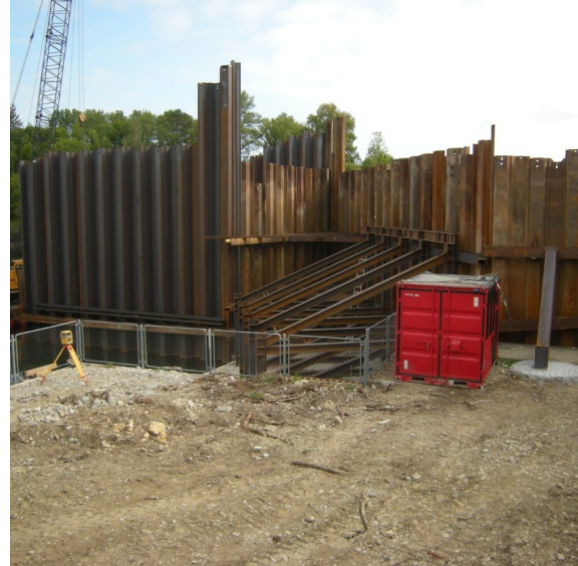
14. Abstützung Baugrubenumschliessung (Bockkonstruktion - Bild von Seite)
