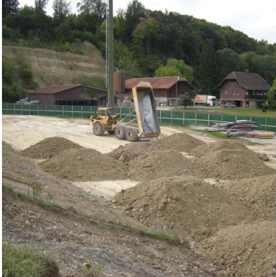
9. Erdarbeiten beim linken Damm
