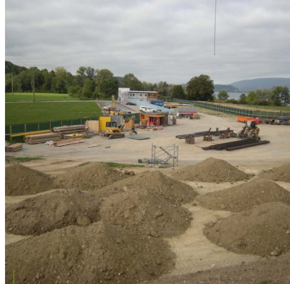
10. Blick auf Installationsplatz
