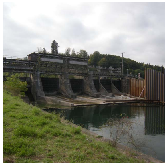
16. Sicht auf Wehr mit Baugrubenumschliessung
