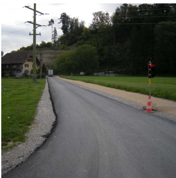
3. Zufahrt zum Installationsplatz
