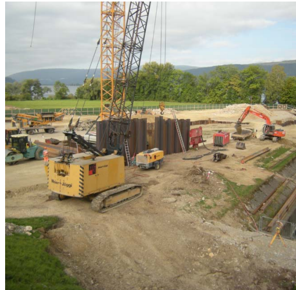
12. Spundwände linkes Ufer
