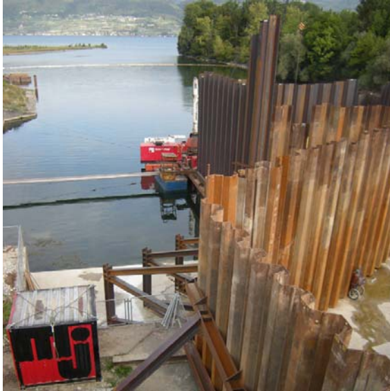
13. Rechter Teil der Baugrubenumschliessung (im Vordergrund mit Bockkonstruktion, im Hintergrund Kastenfangedamm)
