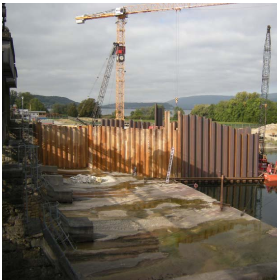
15. Sicht auf Baugrubenumschliessung
