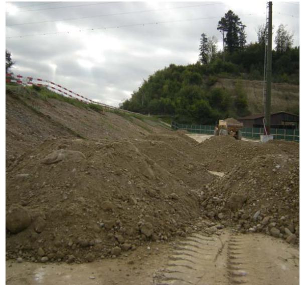
8. Erdarbeiten beim linken Damm
